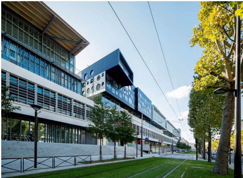
Le Cargo 157 boulevard Macdonald 75019 Paris
